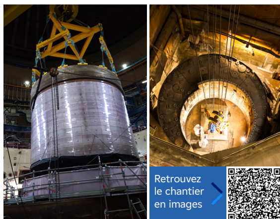
Photo du Petit Bouchon Tournant lors de son extraction (à gauche) et lors de son évacuation après sa découpe (à droite)
